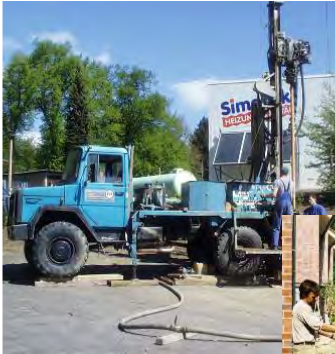
Бурильный станок на автомашине Unimog
